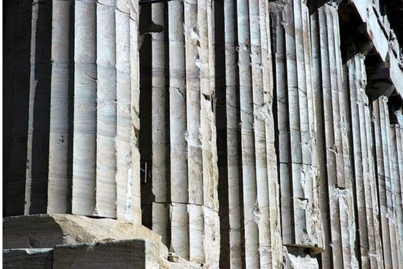
Εικ. 1.1: Φθορές σε κίονες του Παρθενώνα
