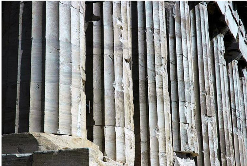
Εικ. 1.1: Φθορές σε κίονες του Παρθενώνα
